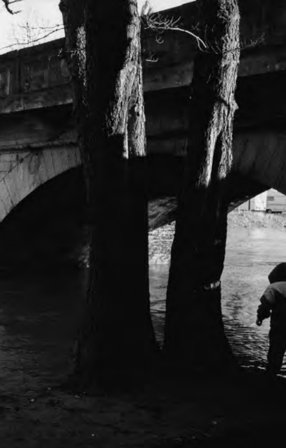
Schießplatzbrücke vom fig. 163 KaWe (heute Eitzenhöfer) aus fotografiert. Aufnahme 1988.
