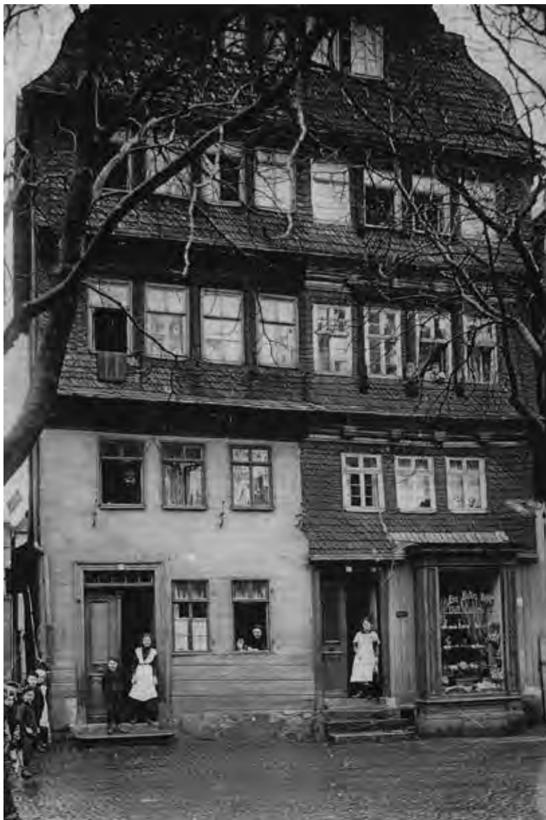
H aus Kornmarkt 15/17 erbaut von Magdale- na Pasor 1617. Später wohnten hier die Familien Nies und Dehnert. Aufnahme aus den 1920er Jahren.
